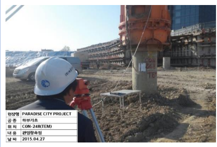
관입량, Rebound 량 측정
