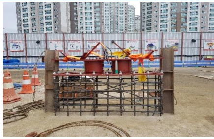
재하장치 하부 철근망 연결
