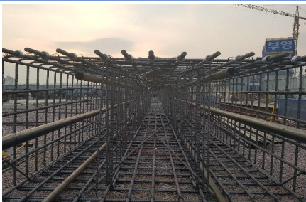
하중전이 센서 설치
