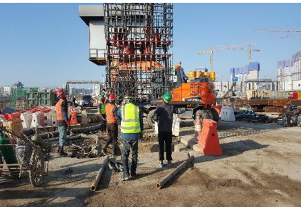
재하장치 철근망 근입
